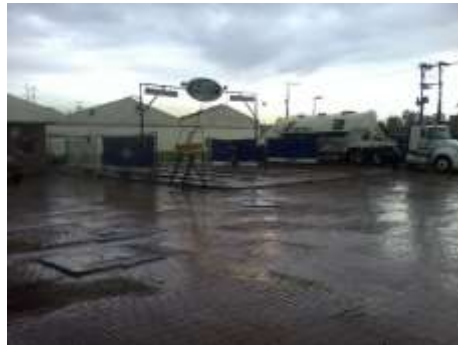
Fotografía 5. Lavadero ubicado en el predio, el cual comparte red de acueducto y aguas residuales
